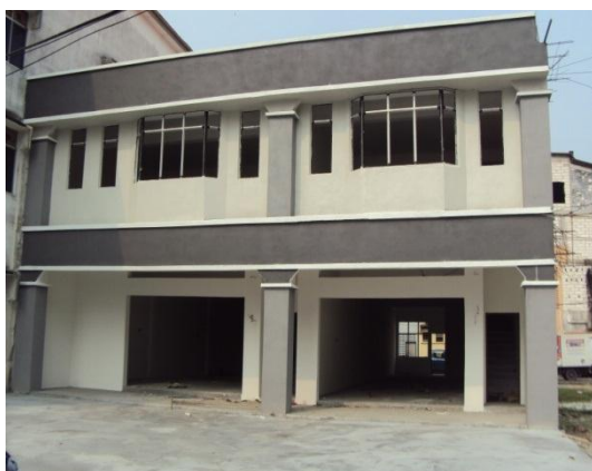
Gambar 2.3 Pembinaan 2 Unit Kedai Pejabat Tidak Mengikut Pelan Bangunan
