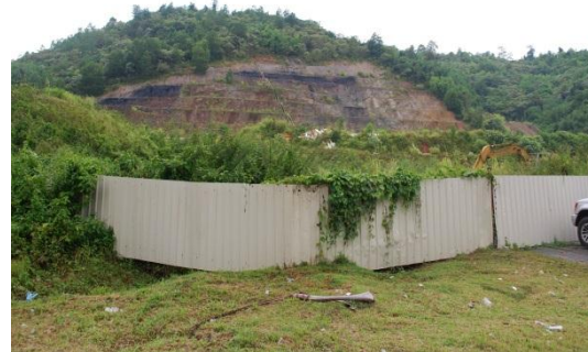
Sumber: Jabatan Audit Negara Lokasi: Pengkalan Hulu Tarikh: 23 September 2014
