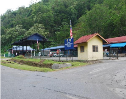
Gambar 1.5 Bangunan MDPH Di Lokasi Projek
